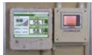
▲デマンド監視装置
