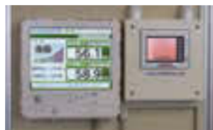
▲デマンド監視装置
